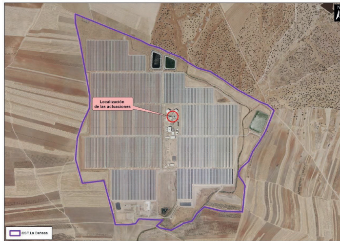
Fig. 1. Localización actuaciones dentro de la Central Solar Termoeléctrica
