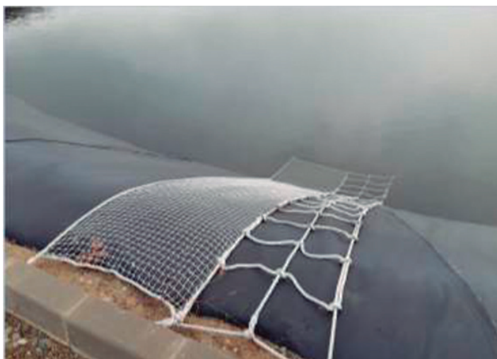
Entramado de cuerdas de diferentes secciones y cuadrículas para la salida de fauna de mediano y gran tamaño.
