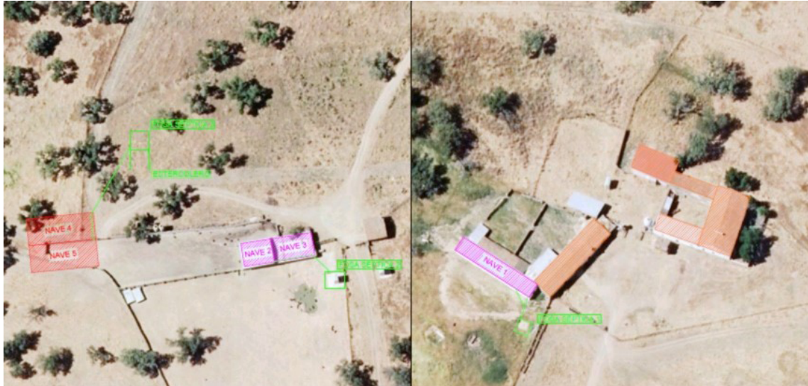
Fig.1. Vista general de las naves e instalaciones auxiliares.
