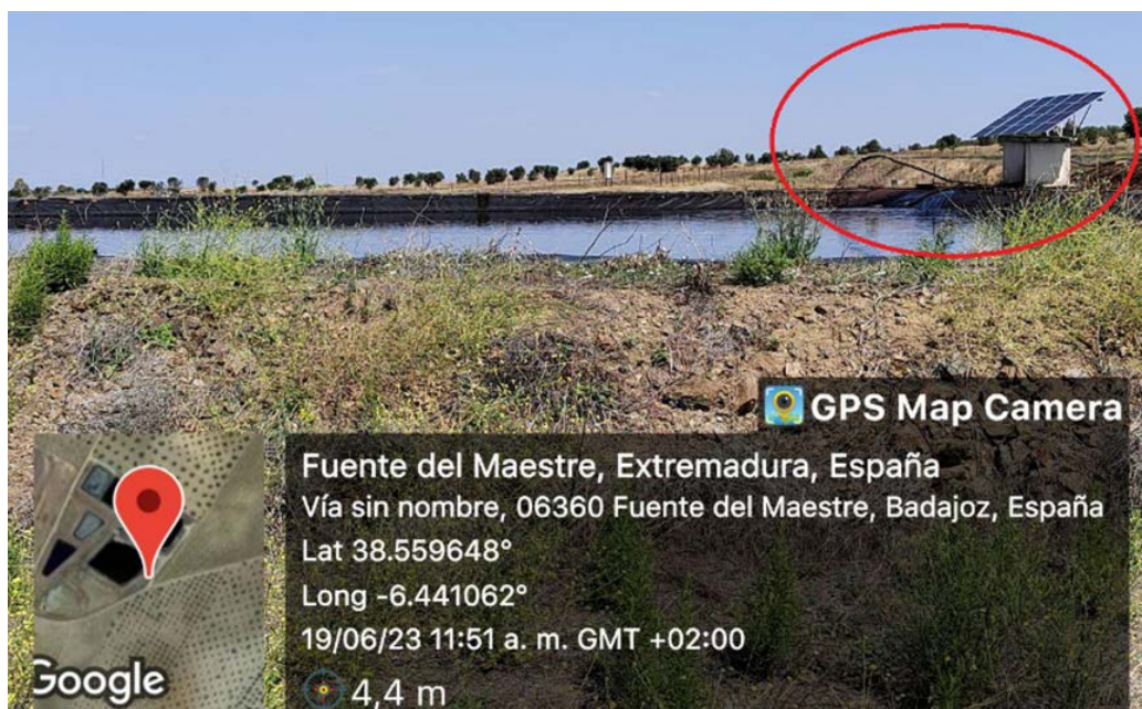
F4. Imagen del drenaje del interior a la superficie de la lámina de agua de la balsa a través de una manguera a partir de un sistema de bombeo.
