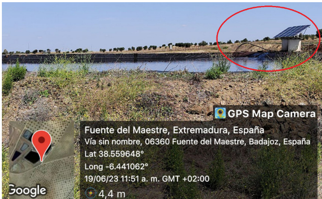
F4. Imagen del drenaje del interior a la superficie de la lámina de agua de la balsa a través de una manguera a partir de un sistema de bombeo.
