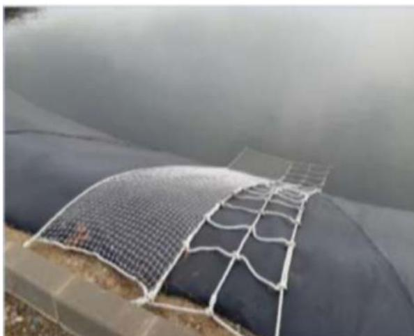
Imagen 2: Entramado de cuerdas de diferentes secciones y cuadrículas para salida de fauna de mediano y gran tamaño.
