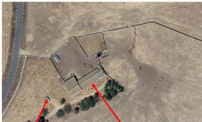
Caseta de instalaciones existente sin intervención Nave agraria de reformar
