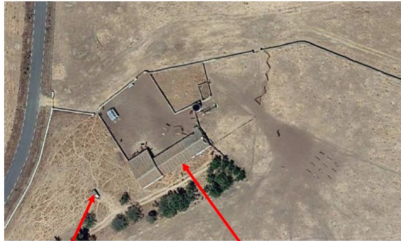
Caseta de instalaciones existente sin intervención
