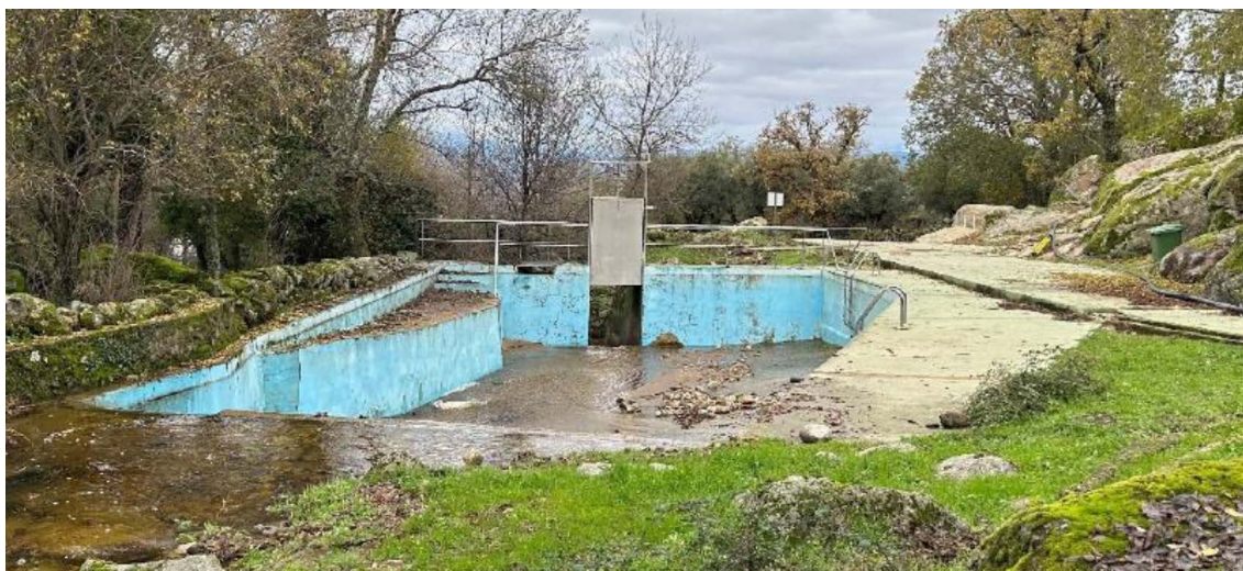
Imagen. Vista general de la zona de baño.
