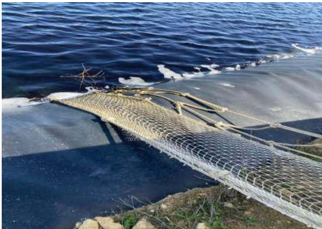
Imagen 1: Redes trepadoras instaladas en la balsa
