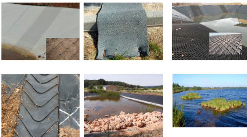
Imagen 1: Materiales aconsejados para la salida de fauna de mediano y gran tamaño (Fuente: Elaboración propia)
