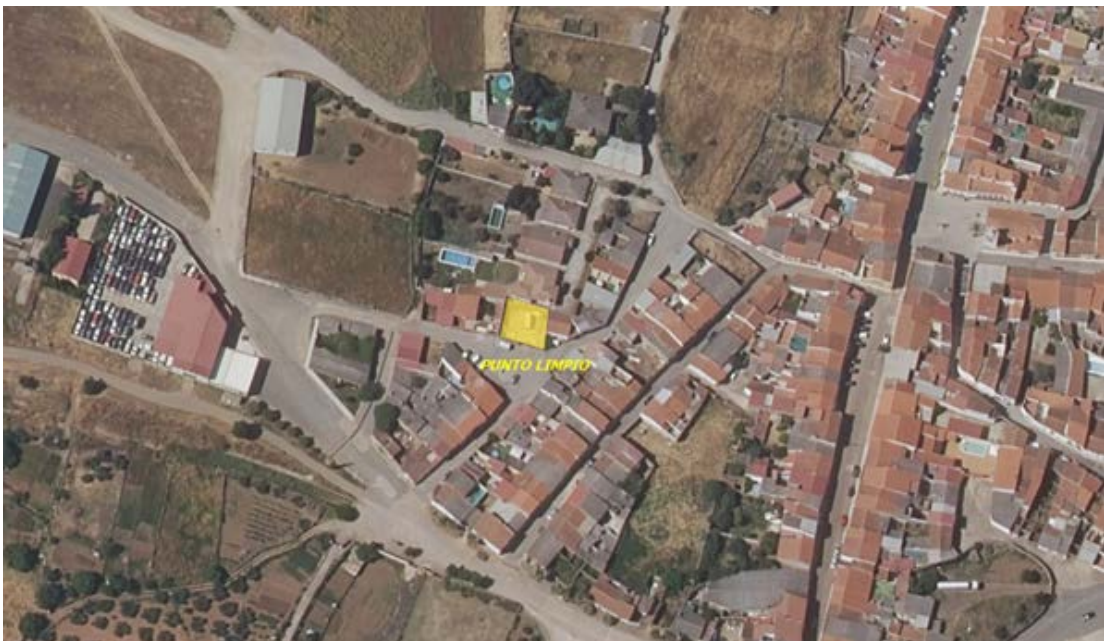
Localización del punto limpio. Fuente: Técnico redactor.
